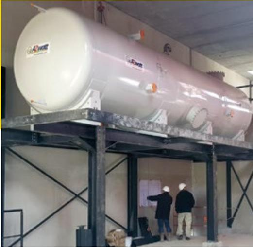
**Descriptif :** Capacité d'expansion pour eau de chauffage ou eau de refroidissement sur cahier des charges de 3 à 100 m<sup>3</sup> en position horizontale ou verticale en configuration adaptée spécifiquement à votre local technique ou chaufferie – accessibilité, encombrement, orientation des piquages, montage en série multi-bâches etc.
